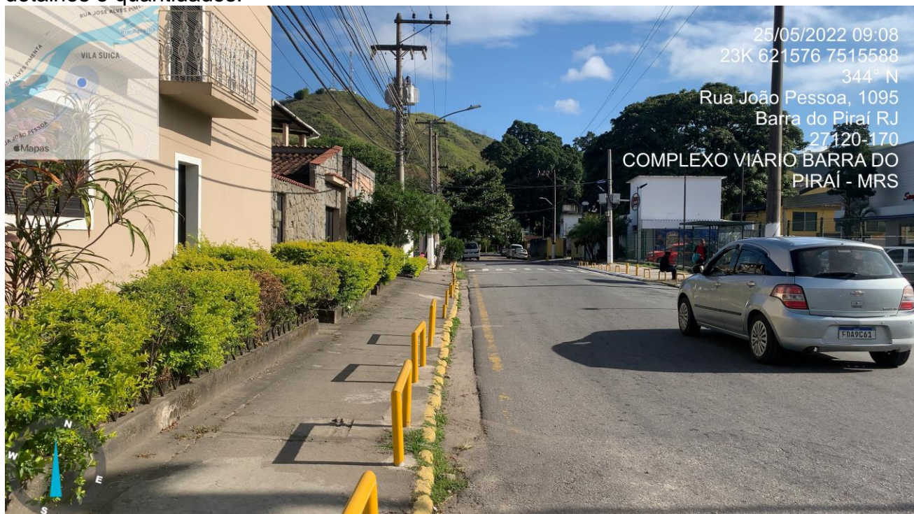
Figura 16 – Pavimento a ser removido
